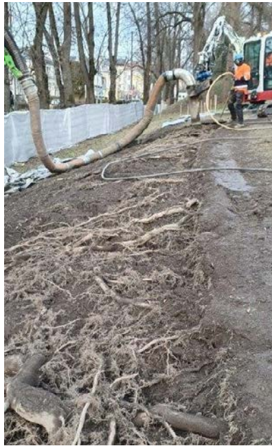
Slottsparken skal behandles som fredet. Det er benyttet luftspade og vakuumgravemaskin for å fjerne jorden omkring trærnes røtter så skånsomt som mulig.
