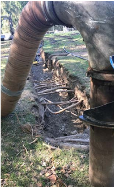
Slottsparken skal behandles som fredet. Det er benyttet luftspade og vakuumgravemaskin for å fjerne jorden omkring trærnes røtter så skånsomt som mulig.
