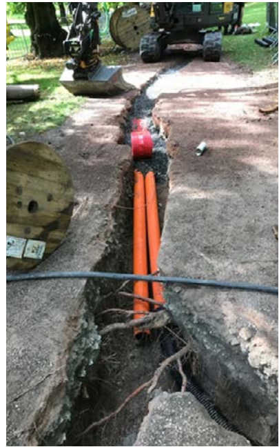
Slottsparken skal behandles som fredet. Det er benyttet luftspade og vakuumgravemaskin for å fjerne jorden omkring trærnes røtter så skånsomt som mulig.
